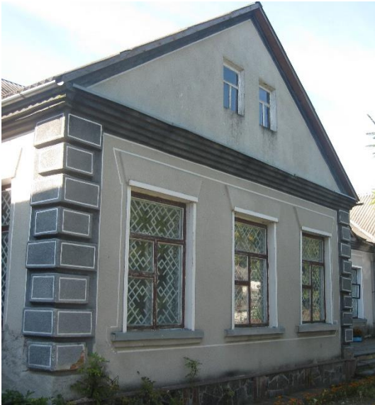
Нежитлова будівля (Житомирська обл., Ємільчинський р-н, с. Бараші)
