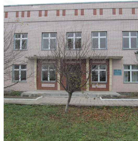
Нежитлові приміщення адмінбудинку (Житомирська обл., смт Романів)
